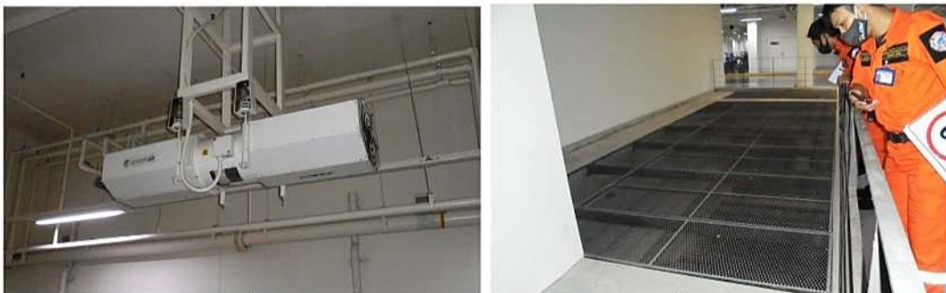
ภาพที่ 4-6 พัดลมระบายอากาศ และช่องระบายอากาศภายในชั้นจอดรถ
