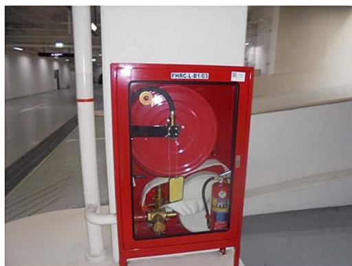
ภาพที่ 4-17 ตู้เก็บสายฉีดน้ำดับเพลิงพร้อมอุปกรณ์ และตู้เก็บอุปกรณ์ดับเพลิง
