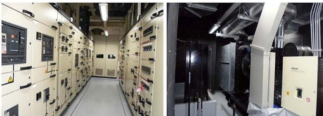
ภาพที่ 4-11 ห้องเครื่องไฟฟ้า MDB และห้องเครื่องไฟฟ้าสำรอง
